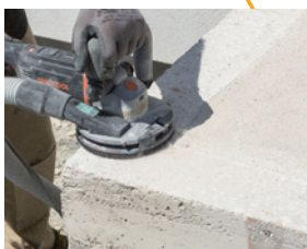
Mittels Handschleifgerät Vertiefung fräsen
