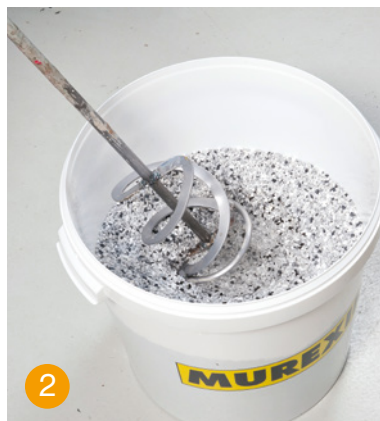
2. Hierzu wird das Bindemittel mit einem langsam laufenden Rührwerk (ca. 400 U/Min.) gründlich mit dem Naturkiesel vermischt.
