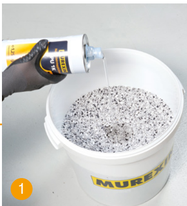
1. Die gewünschte Farbmischung des Marmorkiesel MG 24 grob wird mit dem Natursteinteppichharz PU 1K vermischt.
