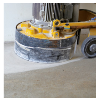
Vorbereiten durch Abschleifen des Untergrundes
