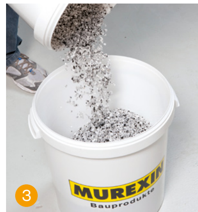
3. Danach wird das Mischgut zur besseren Homogenisierung umgefüllt und neuerlich kurz aufgerührt.
