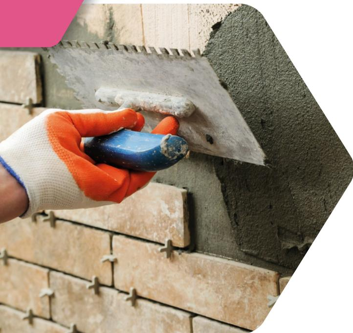
WDVS mit keramischen Belägen können auf massiven Wandbildnern im Neubau oder auf der thermischen Sanierung von Bestandsbauten angewendet werden. Auf Grundlage dieser Technischen Information können Kleinflächen bis. maximal Geschoßhöhe und entsprechender Fugenplanung ausgeführt werden.
